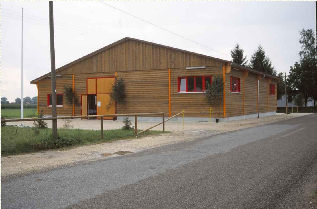
die neue Vereinshalle
